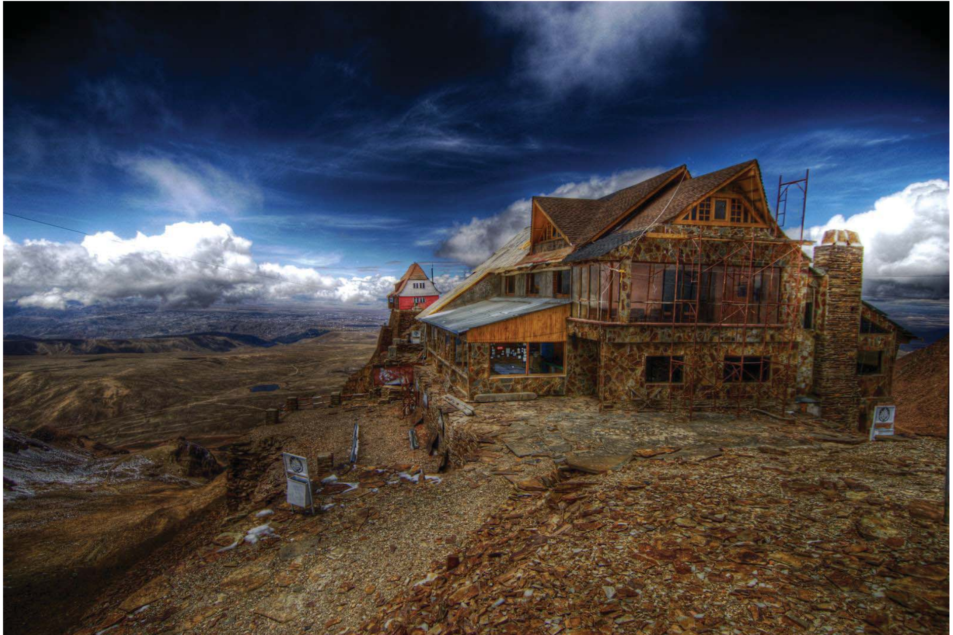
Auswirkungen des Klimawandels auf Bolivien am Beispiel „Chacaltaya“
